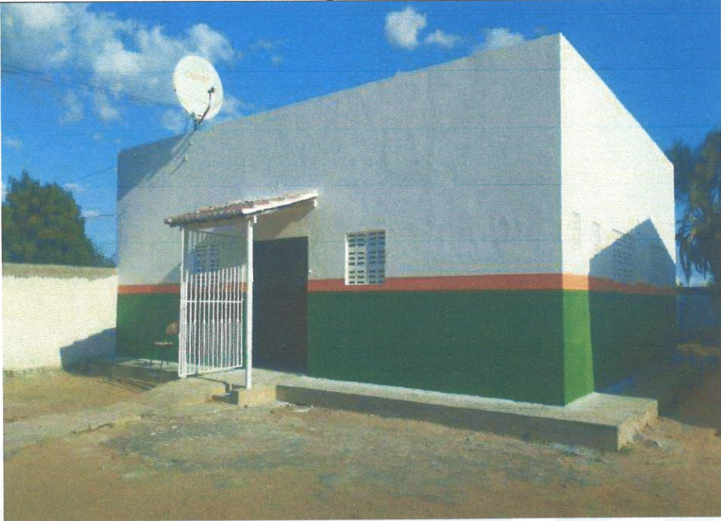
Execução de pintura.
